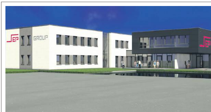
Der Standort der SEP GROUP in Hornstein wird auf eine Betriebsfläche von 2.400 m 2 verdoppelt. SEP Automation GmbH
